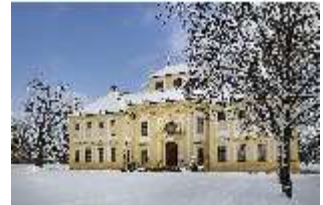
SLH.I, Westfassade verschneit im Winter, DI013812, BSV-
