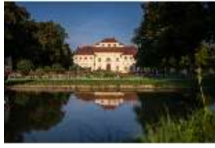
SLH.I, Westfassade, Blick über den Mittelkanal (AF 9), DI027279, BSV
