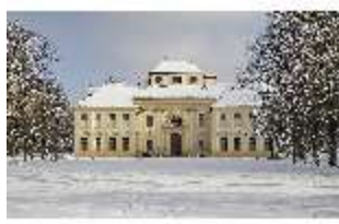
SLH.I, Westfassade verschneit im Winter, DI013815, BSV-
