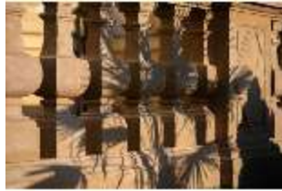
SLH.I, Brüstung am Treppenaufgang der Westfassade (Detail), DI027291, BSV
