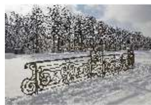
SLH.V, Brücke verschneit im Winter, DI013821, BSV-
