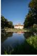
SLH.I, Westfassade, Blick über den Mittelkanal (AF 9), DI027287, BSV
