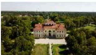
SLH.I, Luftaufnahme von West, DI027330, BSV
