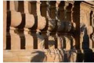
SLH.I, Brüstung am Treppenaufgang der Westfassade (Detail), DI027297, BSV
