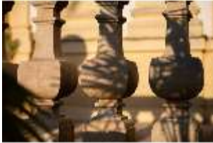
SLH.I, Brüstung am Treppenaufgang der Westfassade (Detail), DI027300, BSV
